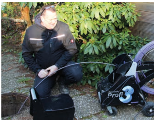
Uwe Brüning überwacht das Abflussrohr während der Injektion. Sollte Schaum eintreten, muss der Vorgang sofort abgebrochen werden.
