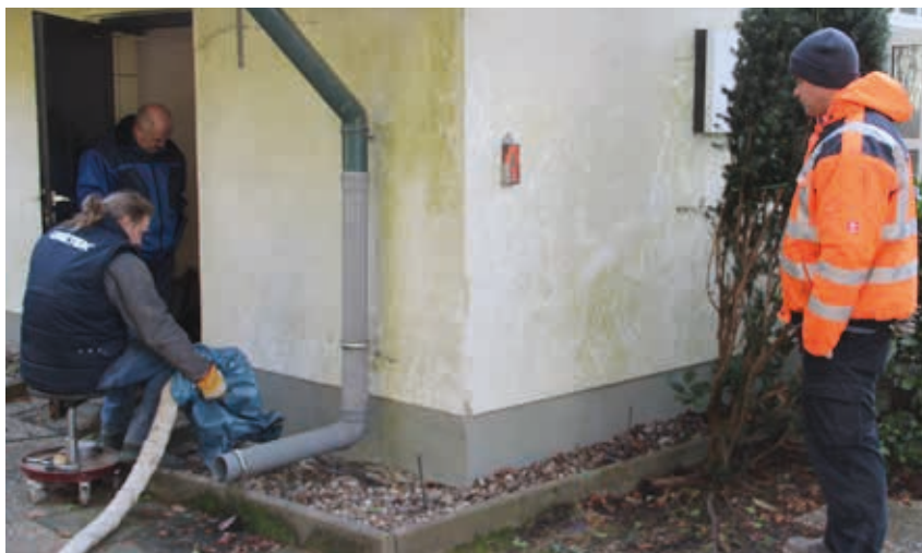
Während Baufachleiter Peter Pajer das Kunstharz in den Boden spritzt, überwacht sein Kollege Kevin Kulbak den Horizontalasser und die Risse im Gebäude. Bilder: Julian Langlotz
